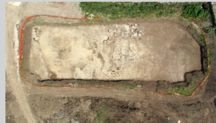
Ciampino (RM) - Cantiere edilizio - scavi archeologici. Ripresa fotografica aerea. Altitudine volo 90 mt. Soprintendenza per i Beni Archeologici del Lazio.
