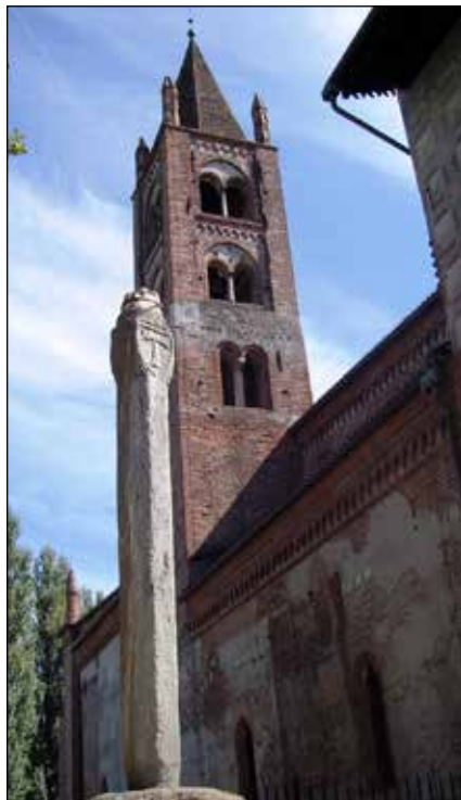
Il masso erratico e sullo sfondo la Torre Campanaria
